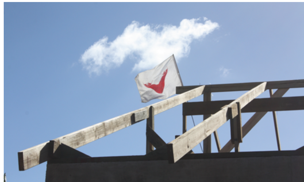
Casa en construcción Foto: Tahira Edmunds, 2020.
