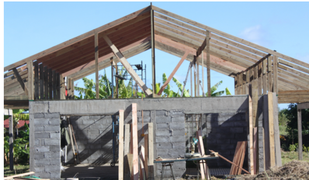
Casa en construcción Foto: Tahira Edmunds, 2020
