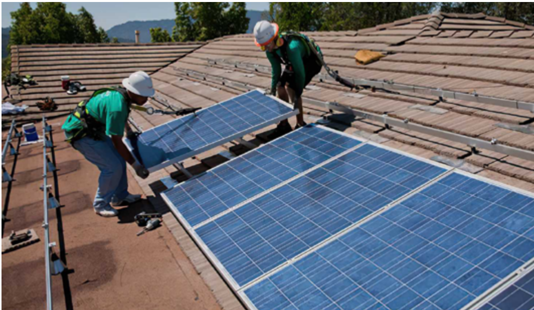
Instalación de panel solar Foto: Chilebeneficios.cl
